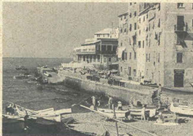
Eine typisch italienische Hinterhausfassade am Strand in Genua.
